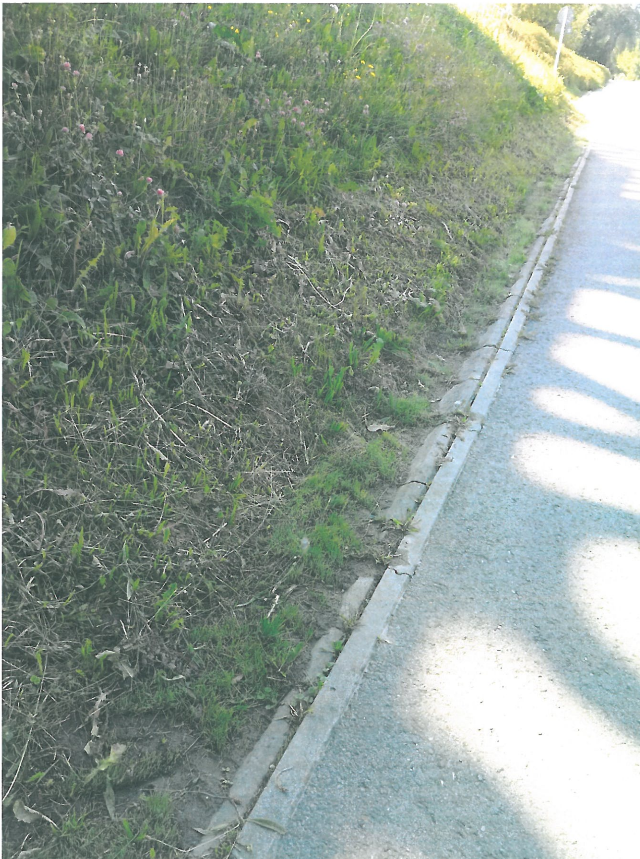
Rysunek 2. Zatkane odwodnienie spływającą ziemią
